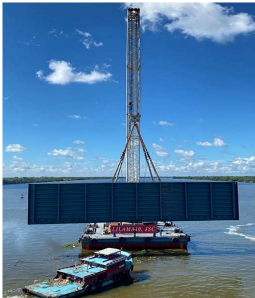
Vận chuyển lắp đặt cửa van nhịp lớn vào công trình.
